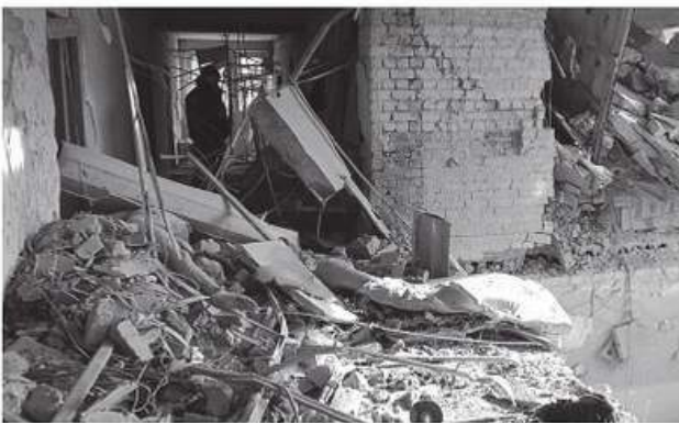
РИС. 11.5. Наслідки вибуху балону з киснево-повітряною сумішшю у Луганській міській лікарні № 7
